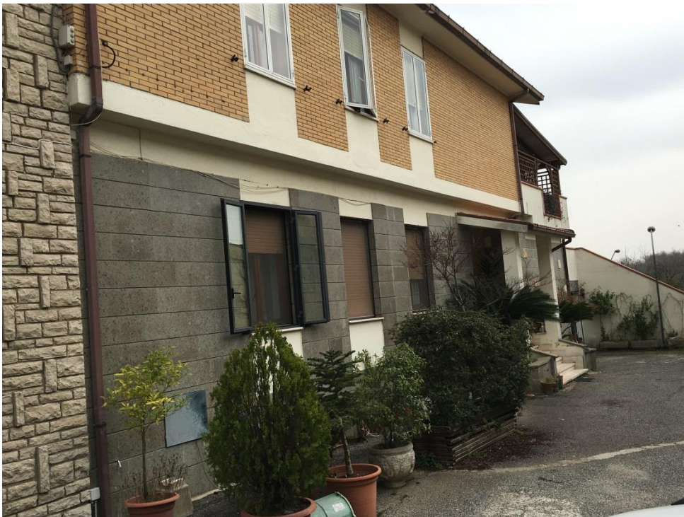
Figura 2: prospetto lato ingresso immobile
